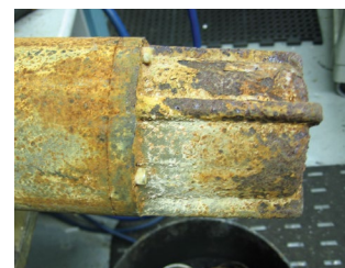
Corrosión/incrustaciones No aplica garantía
