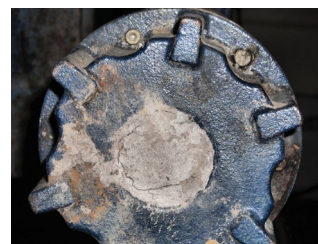
Enterrado en el fondo del pozo
