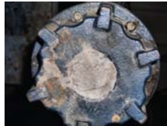
Enterrado en el fondo del pozo
