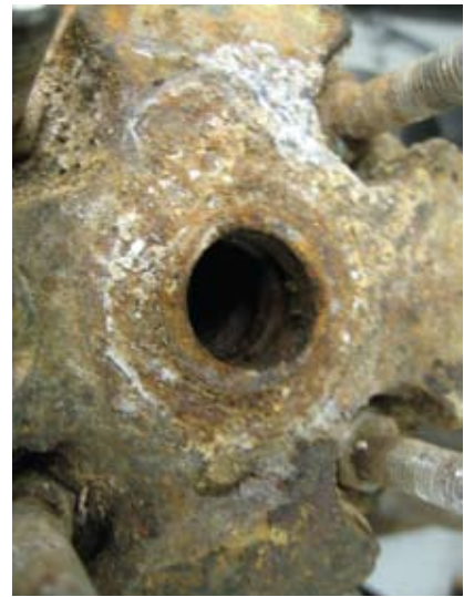
Exceso de corrosión/sarro
